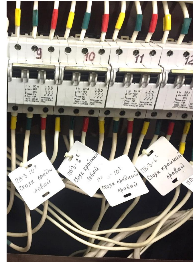
Наличие маркировки на отходящих линиях
